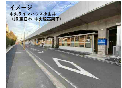
イメージ 中央ラインハウス小倉 (JR東日本 中央線高架下) JR 高架下・乙女通り／学生らが まちにあふれ、暮らす風景をつくる
