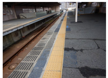
ホーム転落防止（内方線付き点字ブロック）
