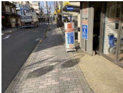
(府)羽衣停車場線の歩道
