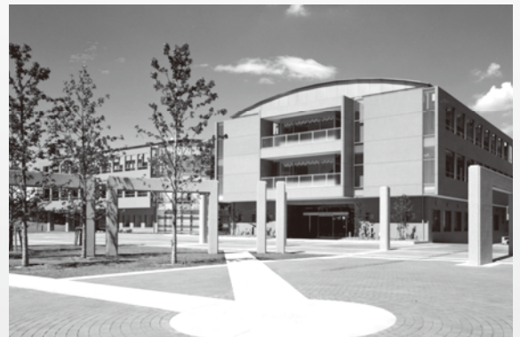
高石市立老人保健施設
