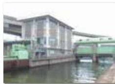
王子川排水機場
