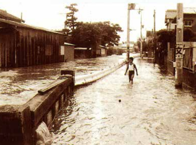
芦田川改修工事のきっかけとなった昭和57年の水害時の羽衣小学校東側を流れる芦田川の様子 [市内の床上・床下浸水含む浸水総戸数1954戸]
