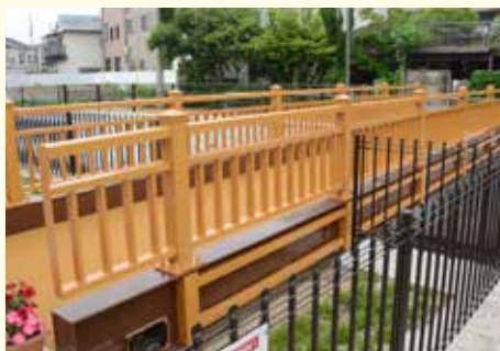
「しまだの橋」の南側（東羽衣7丁目付近）に架けられた「きやらばし」。
