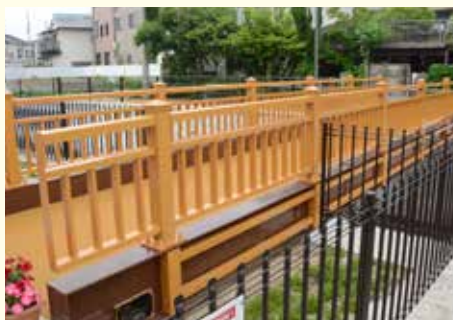
「しまだの橋」の南側（東羽衣7丁目付近）に架けられた「きゃらばし」。
