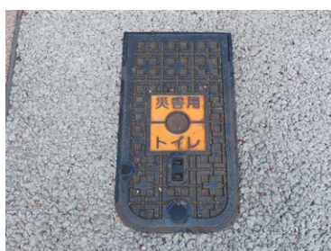
災害用トイレ （高師浜防災広場）
