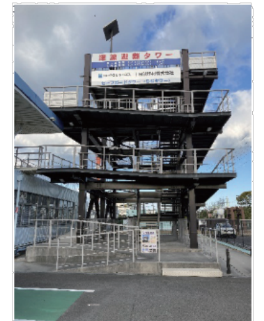
▲ 企業立地等促進制度を適用した防災避難タワー
