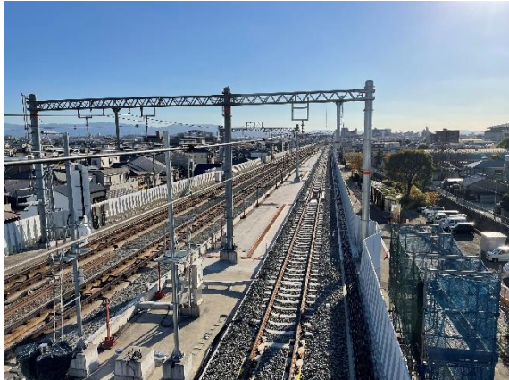
全線高架化完成間近の羽衣駅南側
