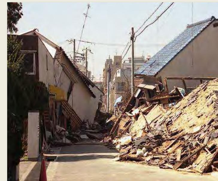
住宅倒壊による道路閉塞(阪神淡路大震災)震度6強
