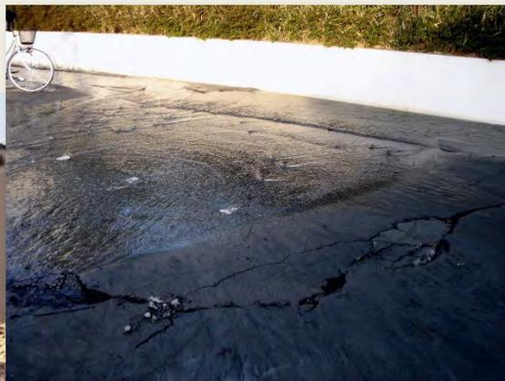
断水(水道管破損による漏水)
