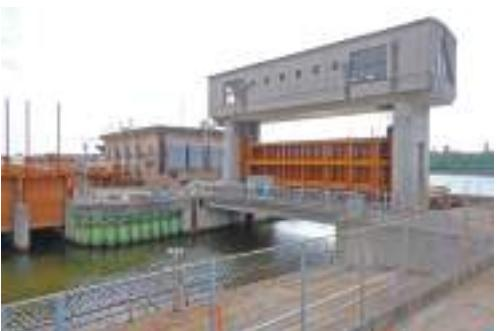
水門は高潮や津波の被害を防ぐために河川などを横切って設けられる施設です。排水機場は高潮や津波の時などに水門が閉められた後、流れてくる河川の水を海に排水することを目的とした施設です。
