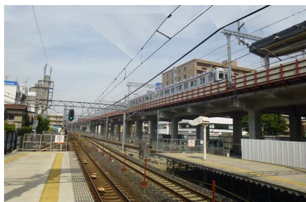
▲下り線高架化後の高石駅
