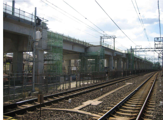
▲上り線高架化工事現場
