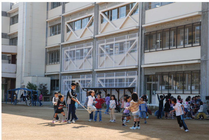
▲耐震化工事が完了した小学校（加茂小学校）
