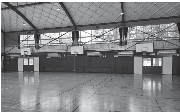
空調が整備された体育館(羽衣小学校)
