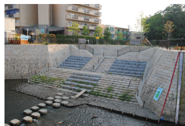
構口公園の階段護岸
