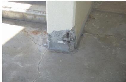
剥離・鉄筋露出
