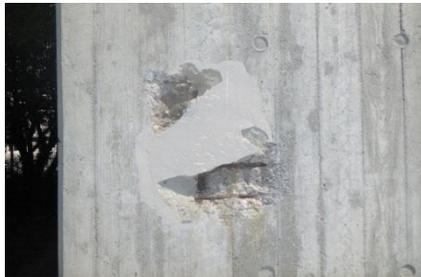
剥離・鉄筋露出
