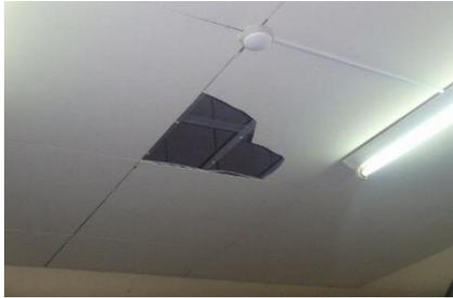
天井ボードの破損
