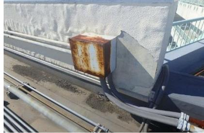
電気設備の腐食
