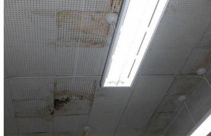
最上階天井の漏水跡
