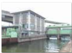
王子川排水機場
