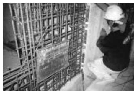
取石中学校 A 棟耐震化工事(平成12年度実施)
