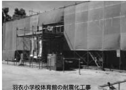
羽衣小学校体育館の耐震化工事
